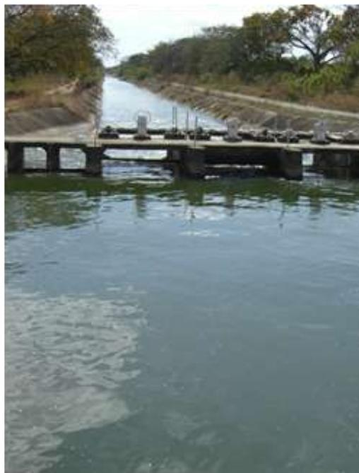
Humedales utilitarios que sirven como fuentes de agua. A la izquierda tubería de 14 pulgadas, en el estado Portuguesa, que mediante bombeo conduce agua de regadío desde los ricos pozos subterráneos del piedemonte andino, hacia campos productores de alimento. A la derecha, sistema de canales y compuertas reguladoras de la salida de agua desde el embalse las Majaguas, estado Portuguesa, hacia campos productores de alimento (fotografías, Crispulo Marrero).
