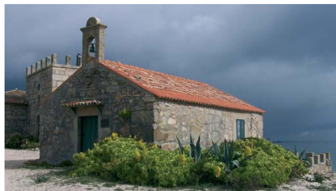
Capilla de la Isla de Sálvora (A Coruña). Fuente: Ambientarte S.L.
