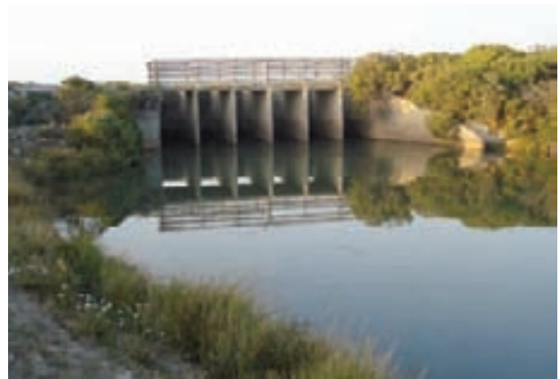
Represa construida en la marisma de la Bahía de Humboldt, California, Estados Unidos.
