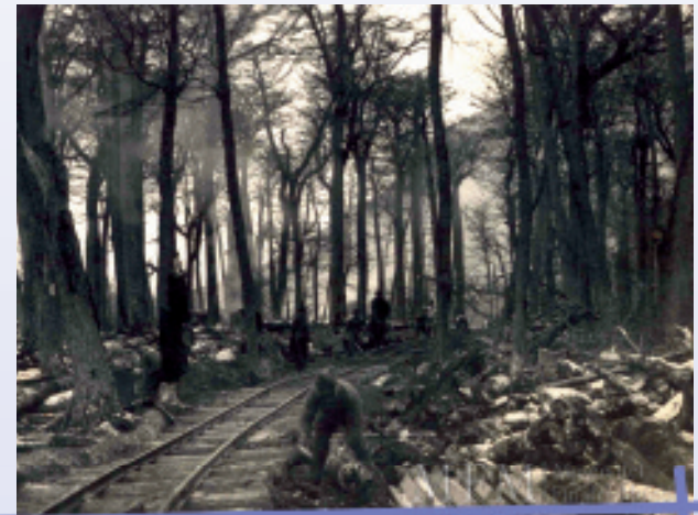
Construcción de las vías del tren.
