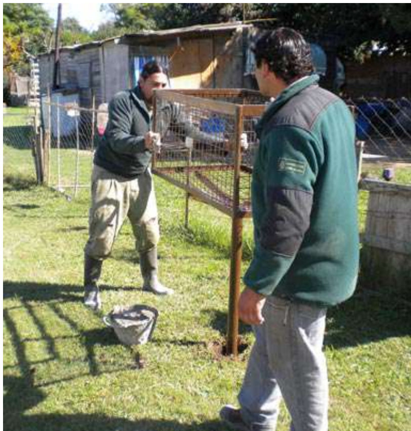
Colocación de los cestos.
